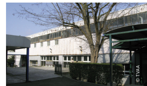
L'ancien bâtiment de la rue Victor-Hugo, réhabilité, abrite l'accueil et les salles d'enseignement général.
