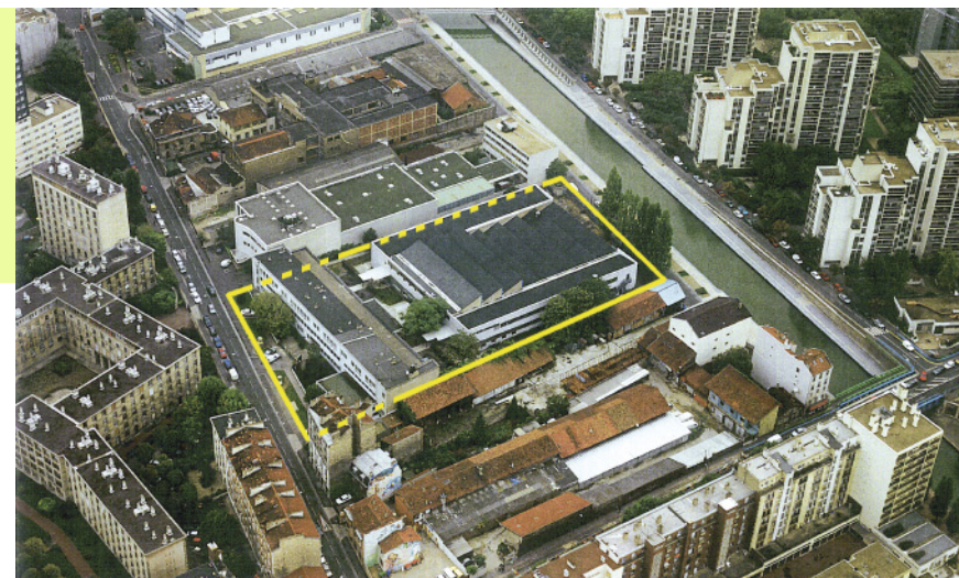
L'implantation du lycée Félix-Faure reprend l'organisation spatiale des entreprises le long de la voie d'eau, l'entrée et les bureaux sont côté rue Victor-Hugo et les ateliers côté canal. Été 1998.
