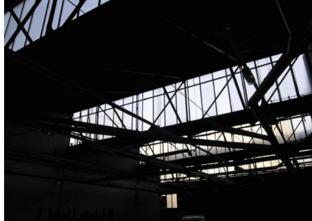
Les anciens toits en shed des ateliers de mécanique.
